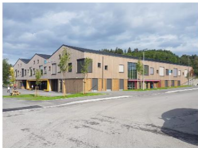
Mære skole og barnehage Ferdigstilt februar 2022
