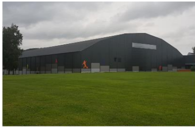
Gulbergaunet fotballhall Ferdigstilt februar 2022
